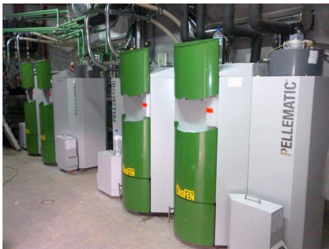
Exemple instal·lació calderes de pèl·let treballant en cascada
