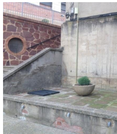
Tapa dipòsit de gasoil de l'Ajuntament
