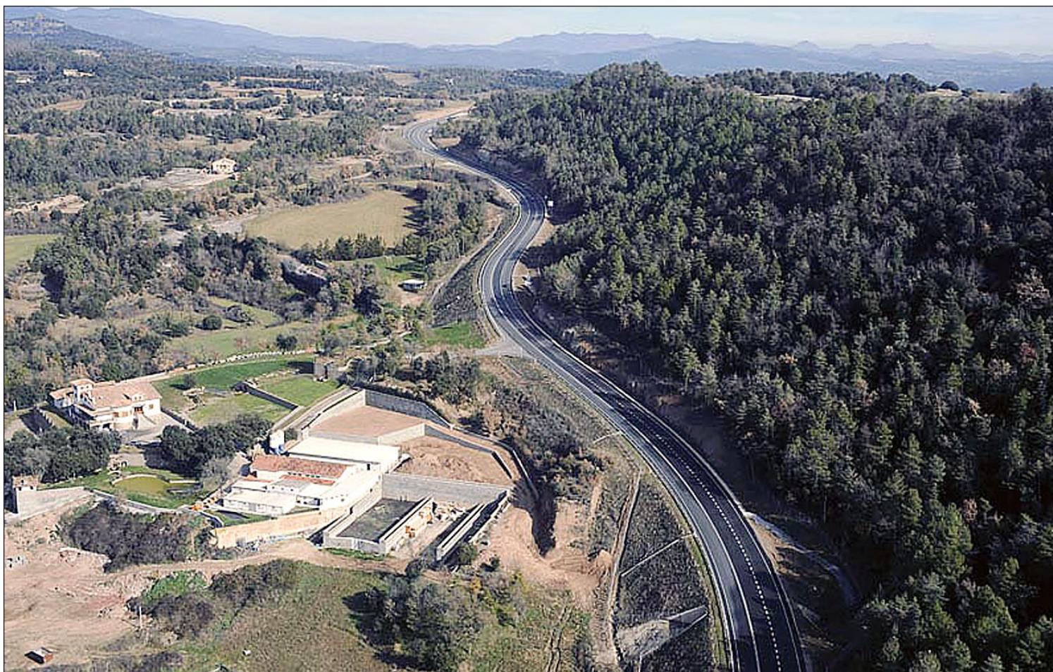
Vista aèria de la nova carretera C-62, entre Olost i Olvan, al seu pas per Santa Maria de Merlès
