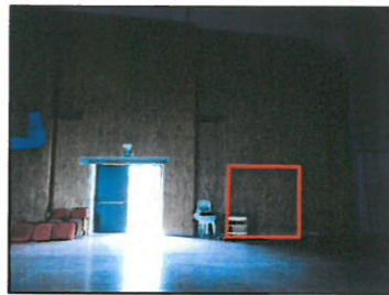
Construcció de sortida d'emergència
