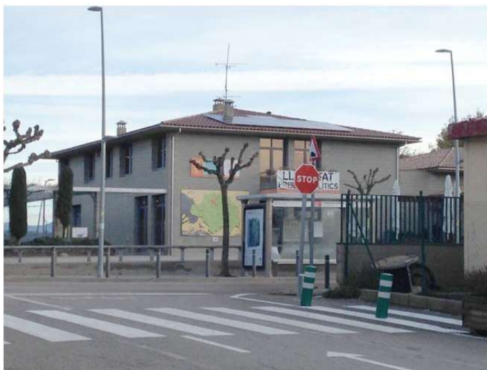
Edifici de l'Ajuntament d'Avià, amb les plaques solars fotovoltaïques en coberta
